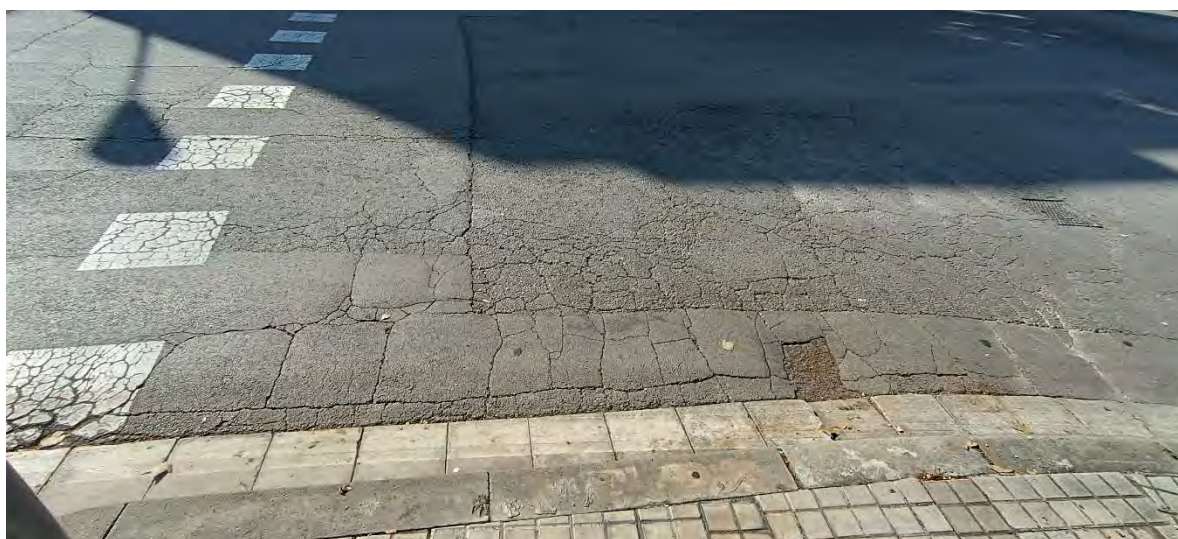
Estat ferm en cruïlla amb C\ Liszt des de gir vorera adjacent a parc
