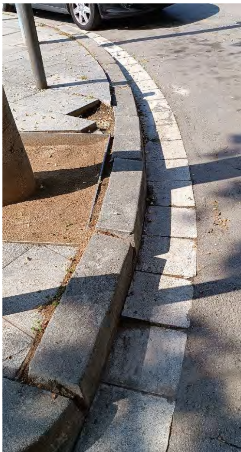
Detall vorada a reparar – Vista detall trobada amb Asfalt Avinguda Mònaco ja reparat.
