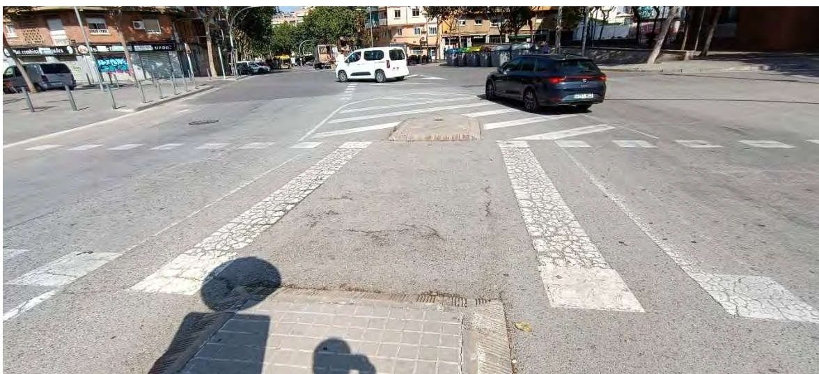
Mitjanes de panot a mantenir – senyalització horitzontal a reposar.
