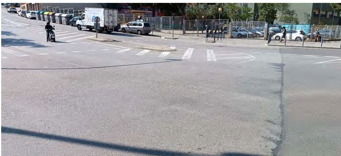
Senyalització horitzontal a reposar – mitjana – pas de zebra... – Tapes de clavegueram a renovar
