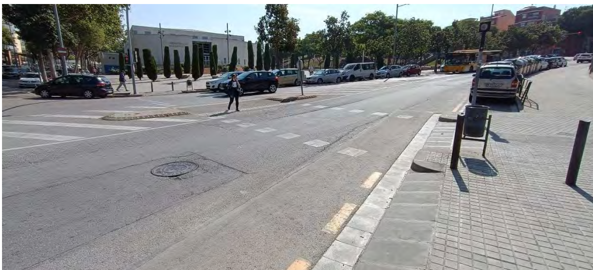
Senyalització horitzontal a reposar – mitjana – pas de zebra... – Tapes de clavegueram a renovar
